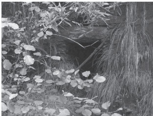
Fig. 6 – Uma das galerias romanas na margem esquerda do rio Mau.
